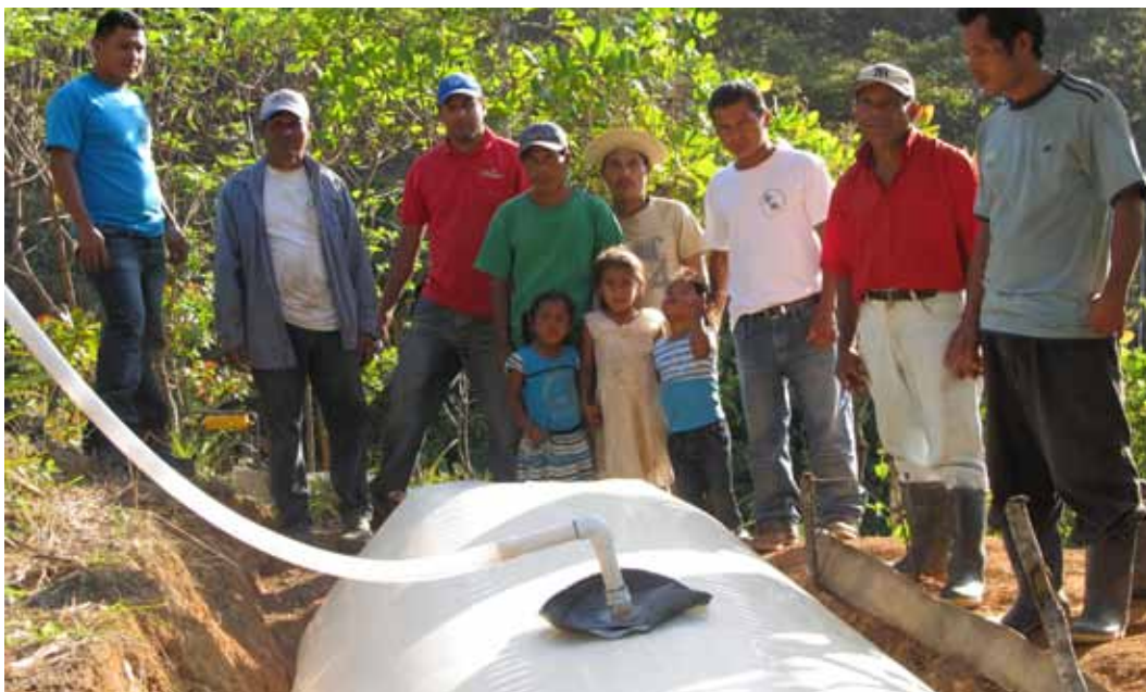
Biodigestor en un 70% de su construcción.
